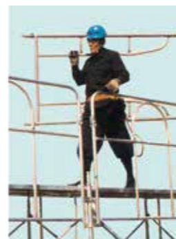
▲建わくを肩に担ぎ、片手はスカイガード手すりにつかまりながら移動中。
