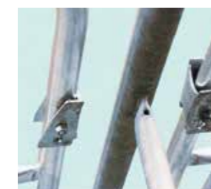
▲建わくを取り付けた時に上部金具は垂直状態になっています。
