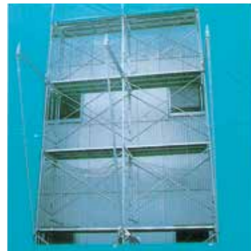
斜材を持ち上げピンをせり、カブラを仮止め
