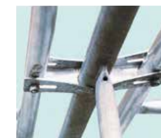
▲上部金具を上へ引き上げ、建わくに水平状態に突きあてた状態。
