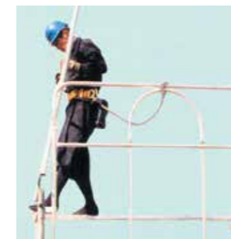
▲足場の先端部に建わくを取り付ける場合にはスカイガードの手すりに安全帯を取り付けます。
