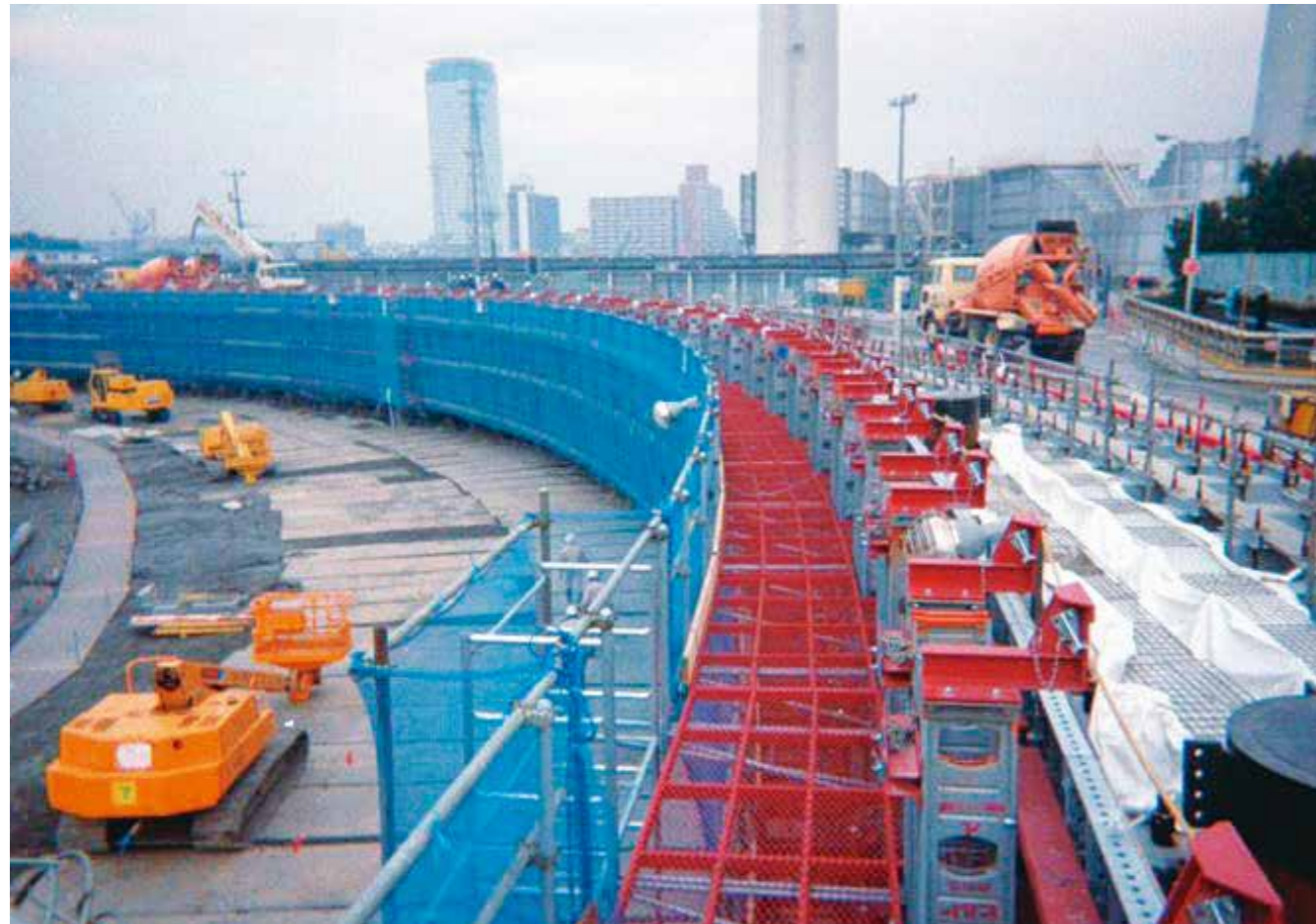
円形コンクリートタンク
