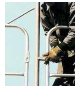
▲建わくに上部金具を突きあてます。
